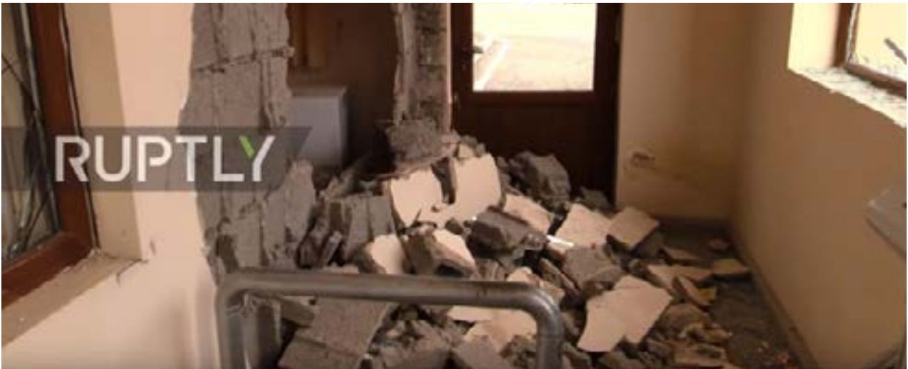
Պատկեր 15.16. Շինության ներքին կառուցվածքային փլուզում, որի հավանական պատճառը եղել է Արցախի փրկարար ծառայության գլխավոր մասնաշենքի հարևանությամբ գտնվող հսկիչ անցակետի վրա արձակված արկի պայթյունից առաջացած արտաքին գերճնշումը, 2020թ. (Աղբյուրը՝ «Ruptly»):
