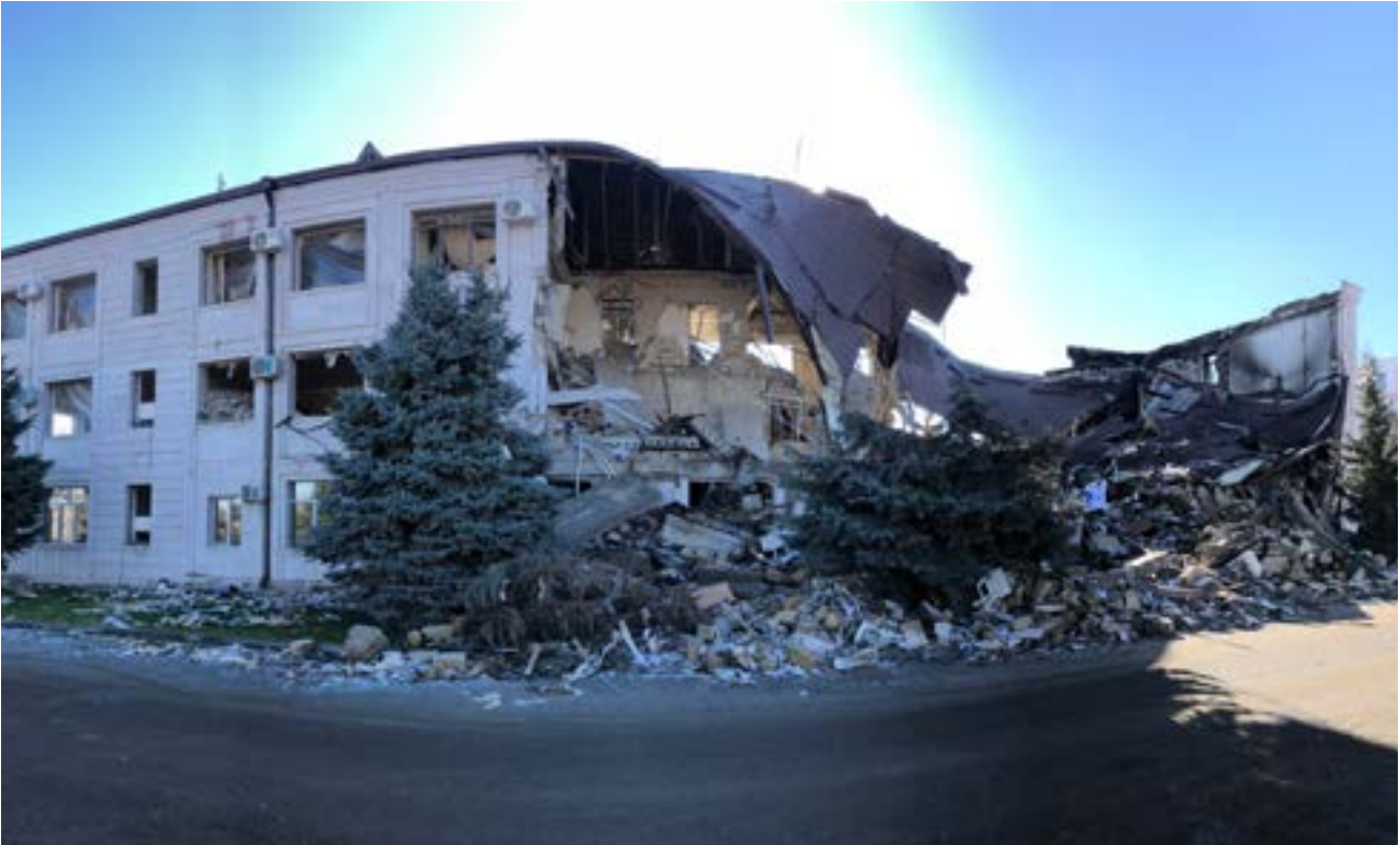
Պատկեր 15.19. «Արցախէներգո»-ի՝ հարձակումից հետո զգալի վնասներ կրած վարչական շենքը Ստեփանակերտում, 4 հոկտեմբերի, 2020թ.: Շենքի կառուցվածքային փլուզումը բնորոշ է մեկ կամ ավելի պայթյուններից վնասված շենքերին (Աղբյուրը՝ փաստահավաք խումբ):
