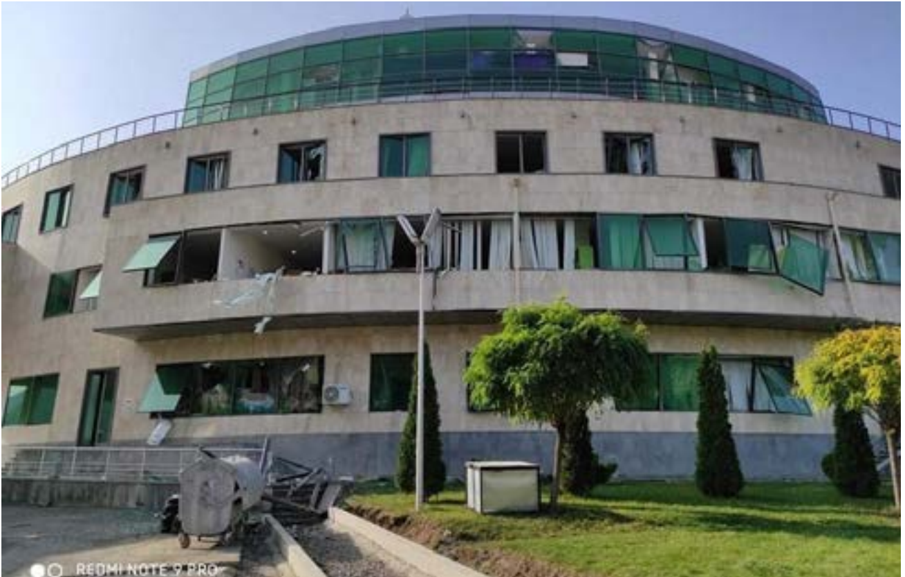
Պատկեր 15.13. Ստեփանակերտի ծննդատան ավերածությունները, 28 հոկտեմբերի, 2020թ. (Աղբյուրը՝ Տիգրան Սկրտչյանի թվիթերյան օգտահաշիվ (@TMkrtchyan)):
