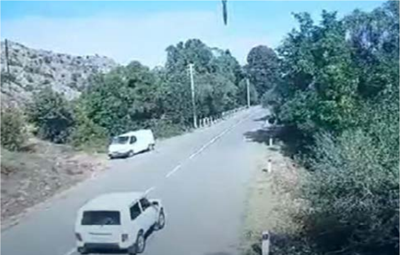
Պատկեր 15.23. Բերձորի կամուրջին հարված հասցնող զինատեսակը՝ հարվածից մեկ վայրկյան առաջ, 2 հոկտեմբերի, 2020թ. (Աղբյուրը՝ «Ա1+»):
